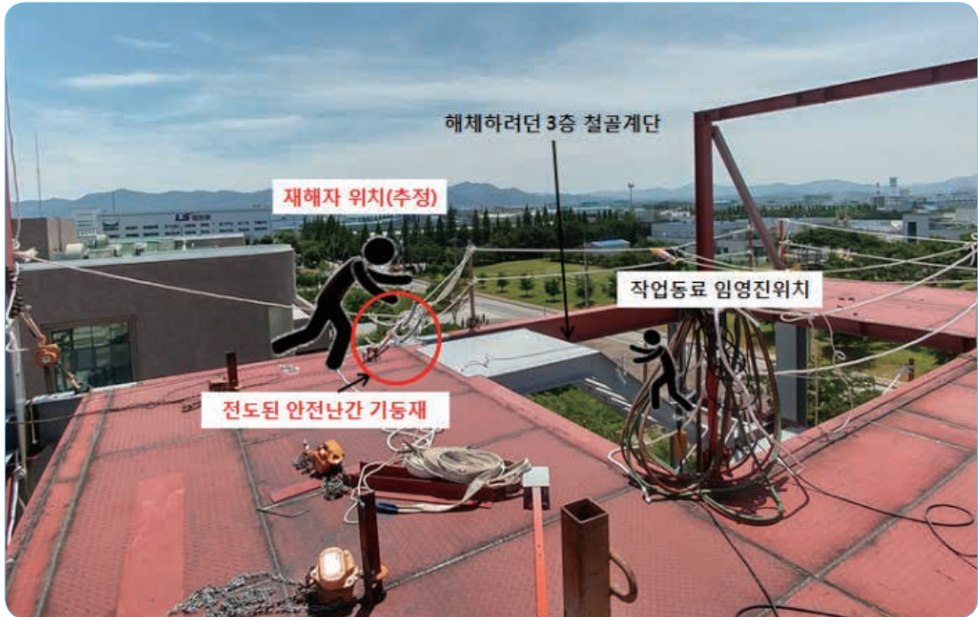
[사진1] 재해자가 서있던 곳으로 추정되는 장소(4층 철판 슬래브)
