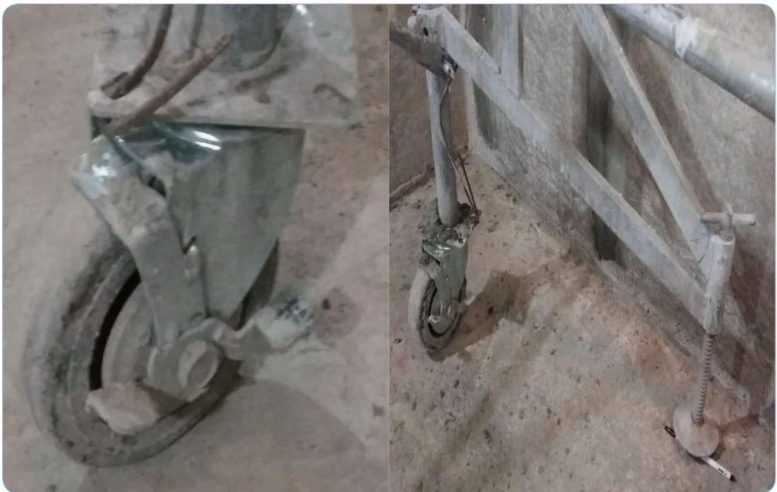
[사진2] 이동식비계 바퀴 스톱퍼 해제(좌) / 아우트리거 미고정(우)
