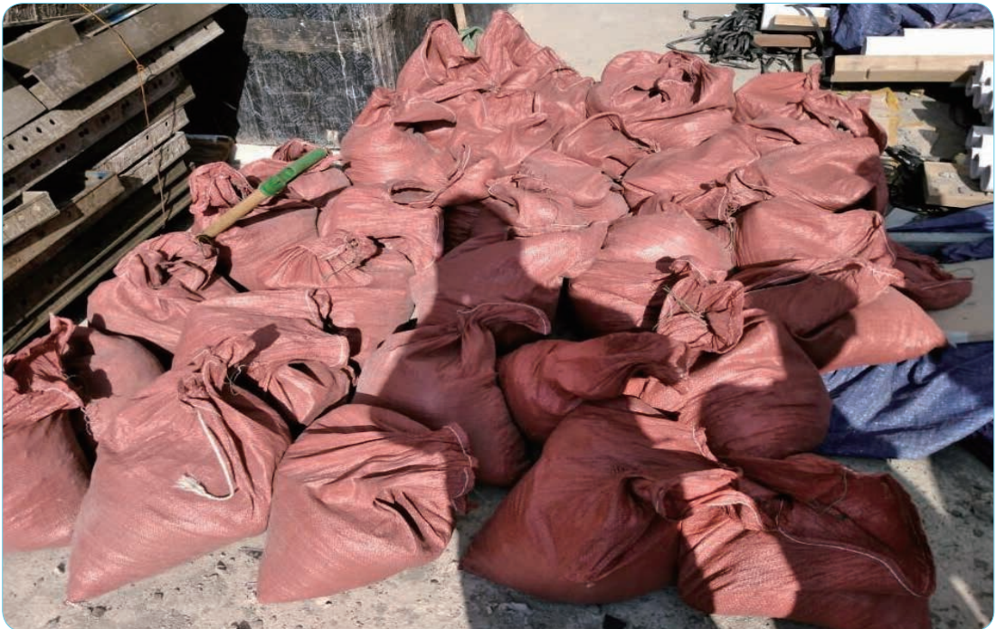
[사진2] 사고로 인해 낙하한 콘크리트 잔재(약 1ton)
