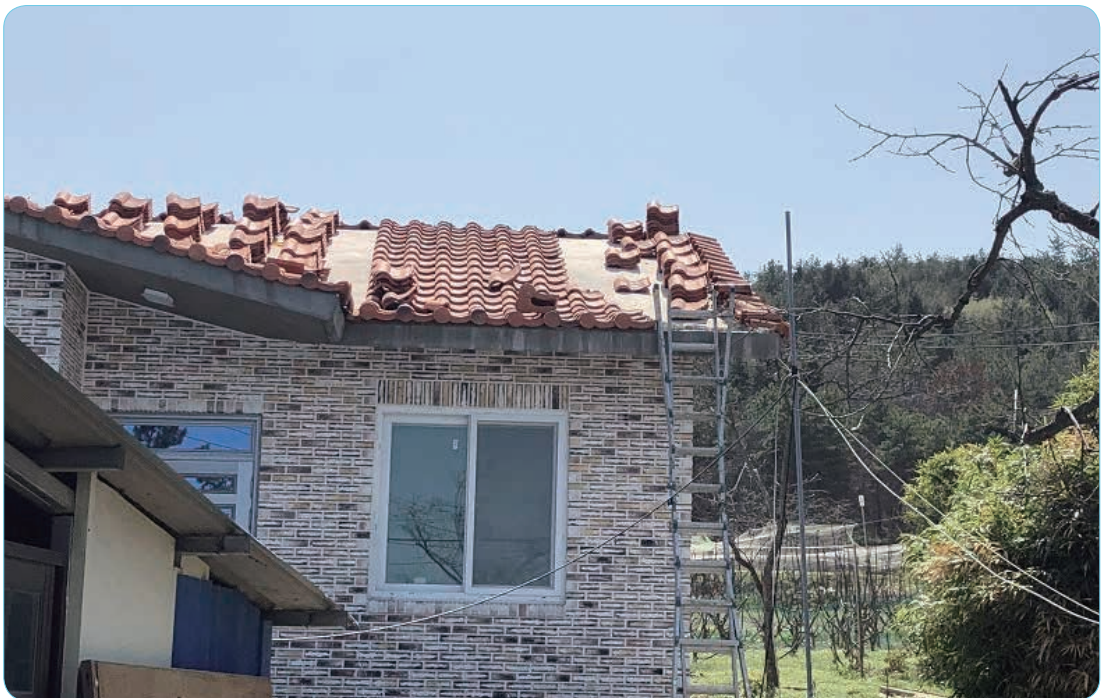
[사진2] 당일 작업을 마친 지붕상태 및 사다리 위치
