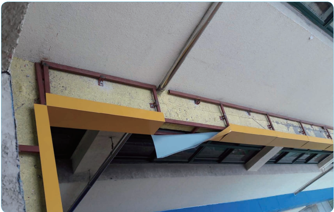
[사진2] 재해자 작업 위치
