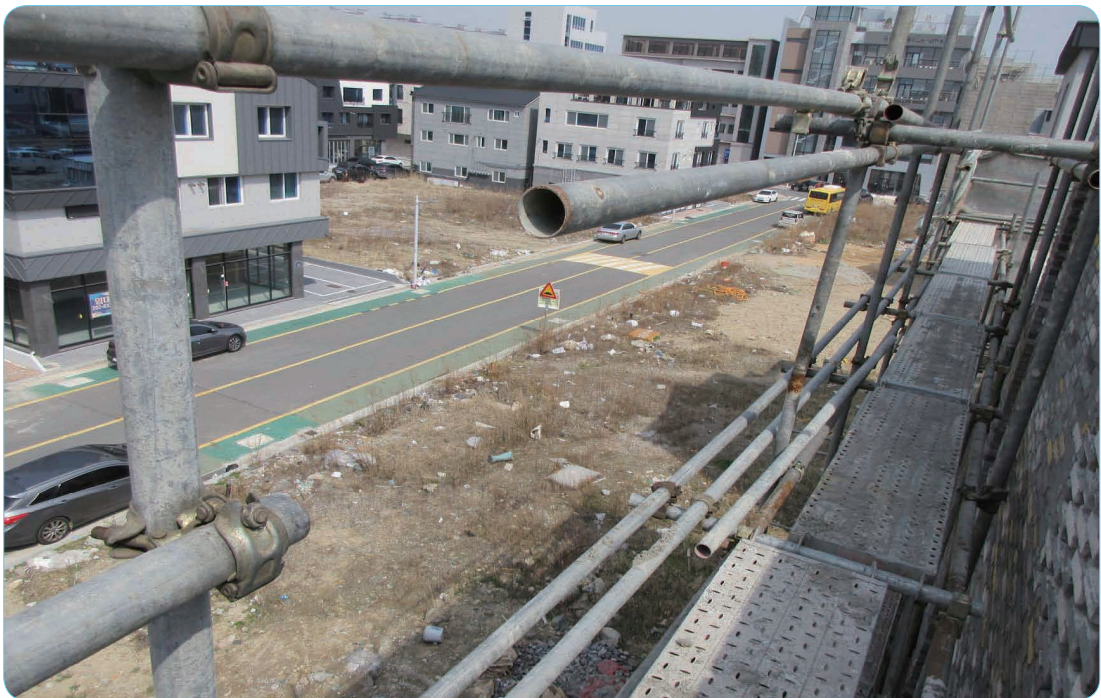
[사진2] 재해자 작업 위치
