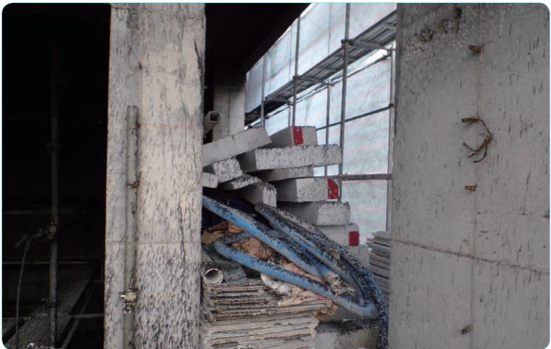
[사진2] 단열재 적재상태(현장 1층 서편)
