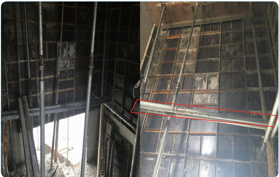
[사진 2] 계단실 내부 발판 설치상태(좌) / 재해자가 이용했던 작업발판(우)
