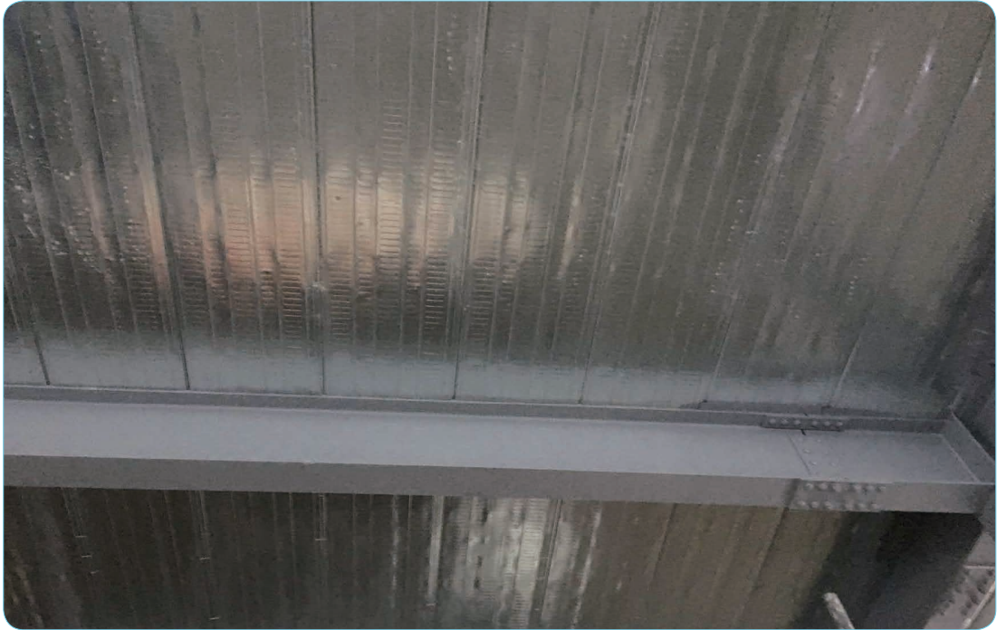
[사진1] 재해자 작업 부위
