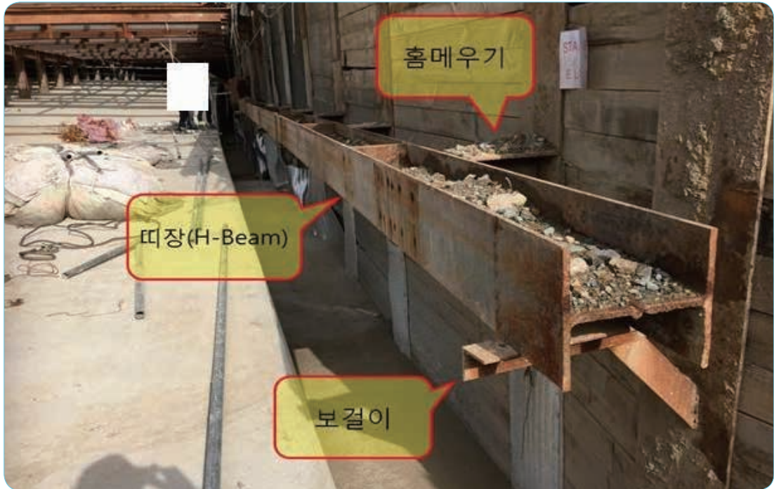
[사진 3] 해체 전 띠장의 모습(사고발생지점 반대편의 동일한 띠장)
