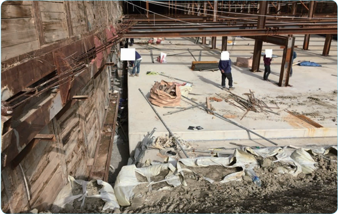
[사진 1] 재해발생 현장전경
