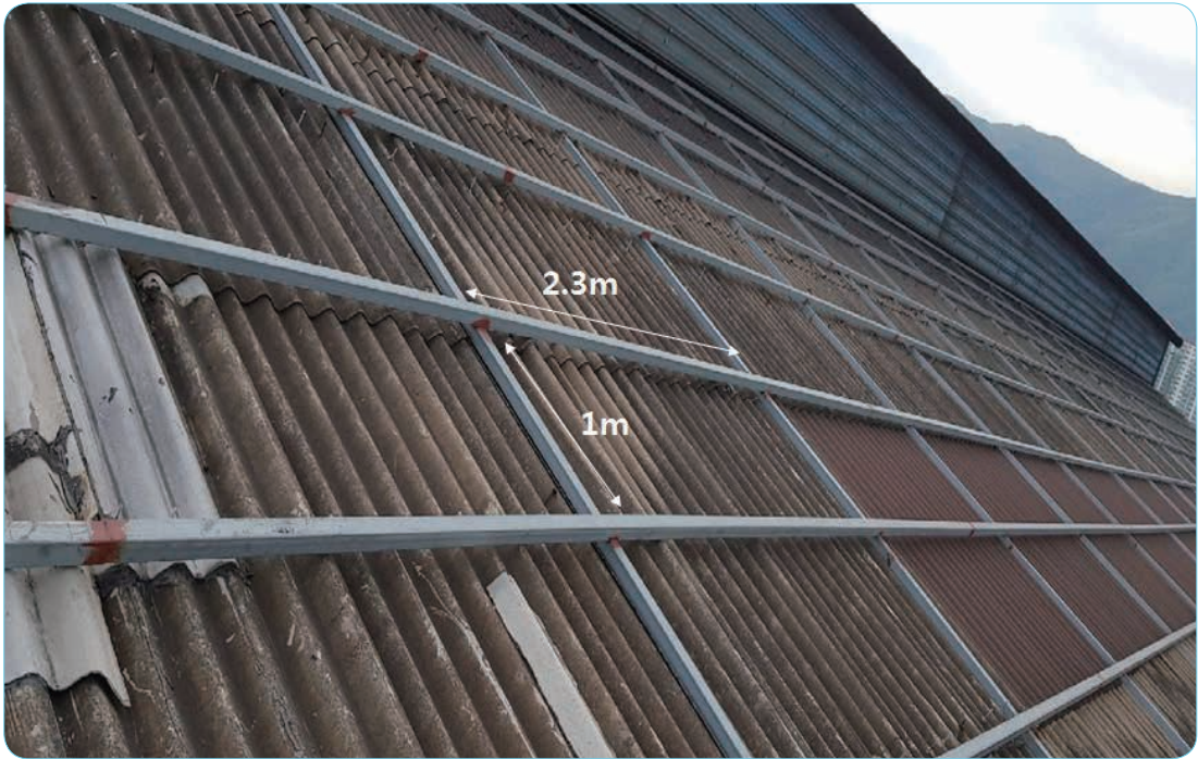
[사진1] 중도리(Purlin) 위에 설치한 사각파이프
