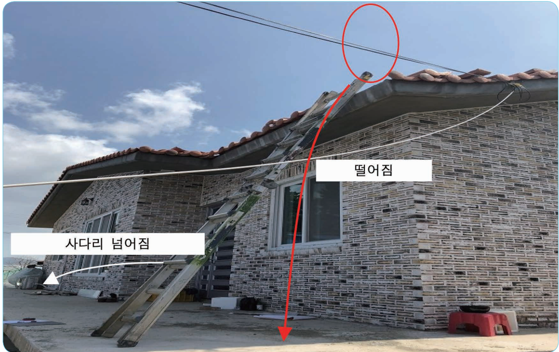
[사진1] 재해발생 현장 전경
